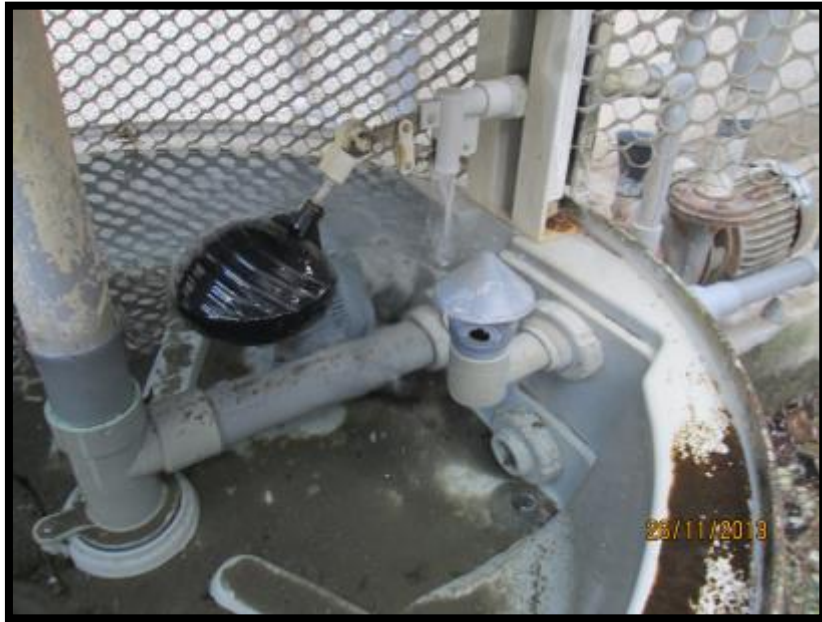
3. 溢位計損壞 不斷補水，整個頂樓環境積水
