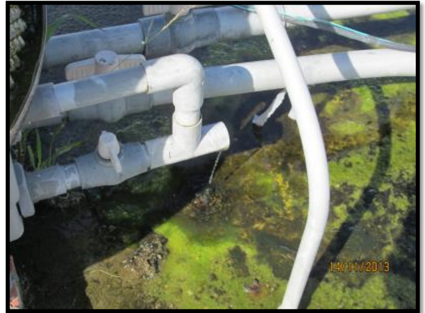
4. 閥門損壞 整個頂樓環境積水 嚴重者屋頂雨排大量排水
