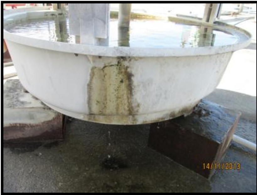
1.冷卻水塔主體有裂縫 需修補或更新
