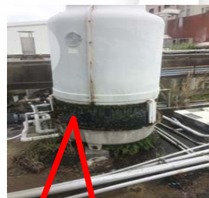
冷卻水塔未清洗保養
